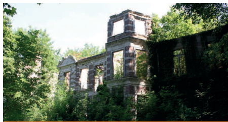
Château villers après l'incendie, 2000
