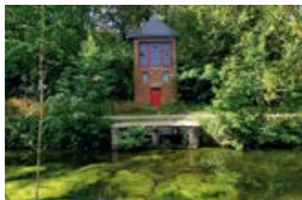
Canal de Seclin © Escapades en Hauts-de-France
