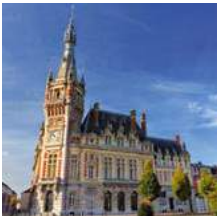
Ancienne chambre de commerce de Tourcoing © César Desoye
