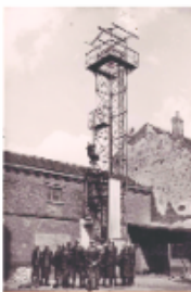
Mazouterie et tour de séchage, 1952
