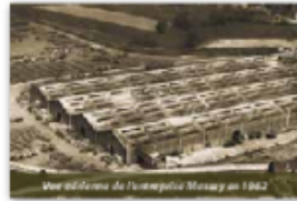
Vue aérienne de l'usine Massey en 1962
